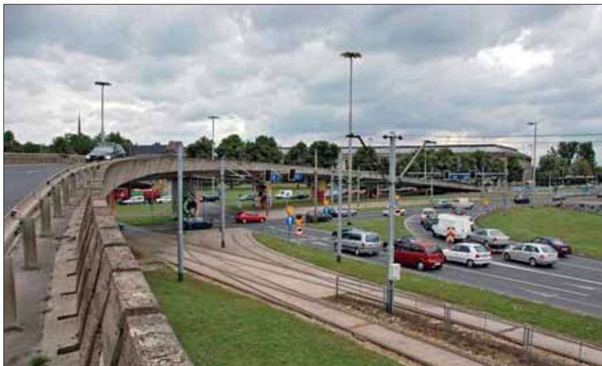
Stacja techniczna estakad budzi duże zastrzeżenia.
